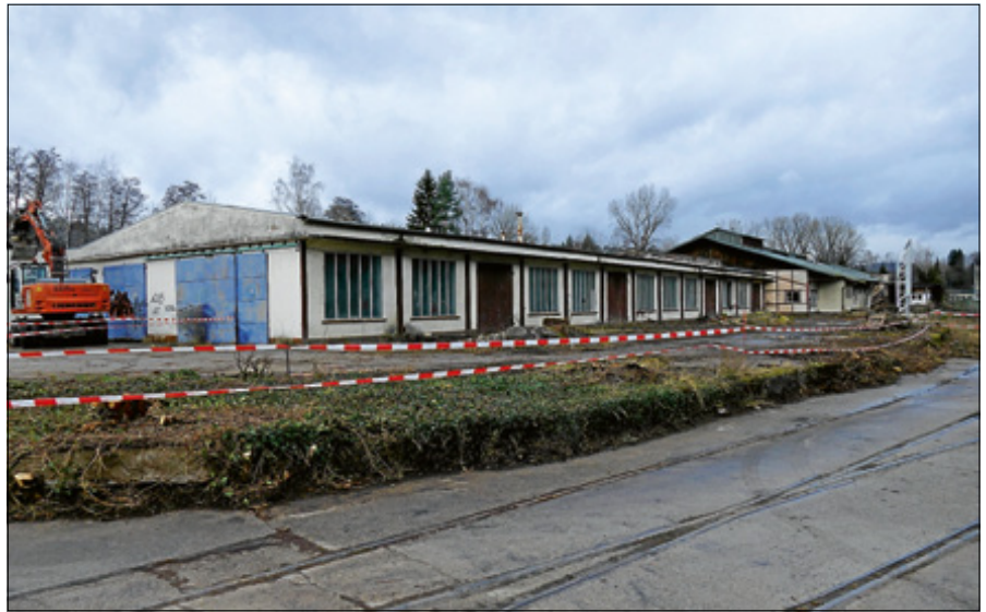
Nach den Rodungsarbeiten erfolgt jetzt der Abriss der Gebäude auf dem Pfeleiderer-Areal. Foto: Stadt Gernsbach
