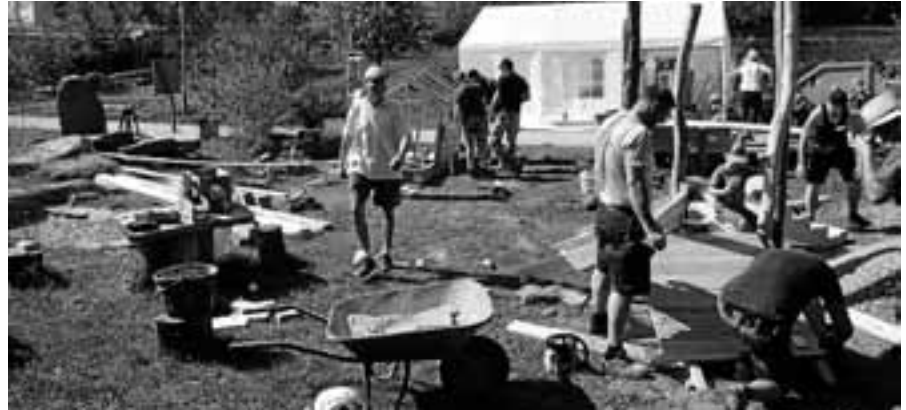
Geschäftiges Treiben auf der Großbaustelle.
