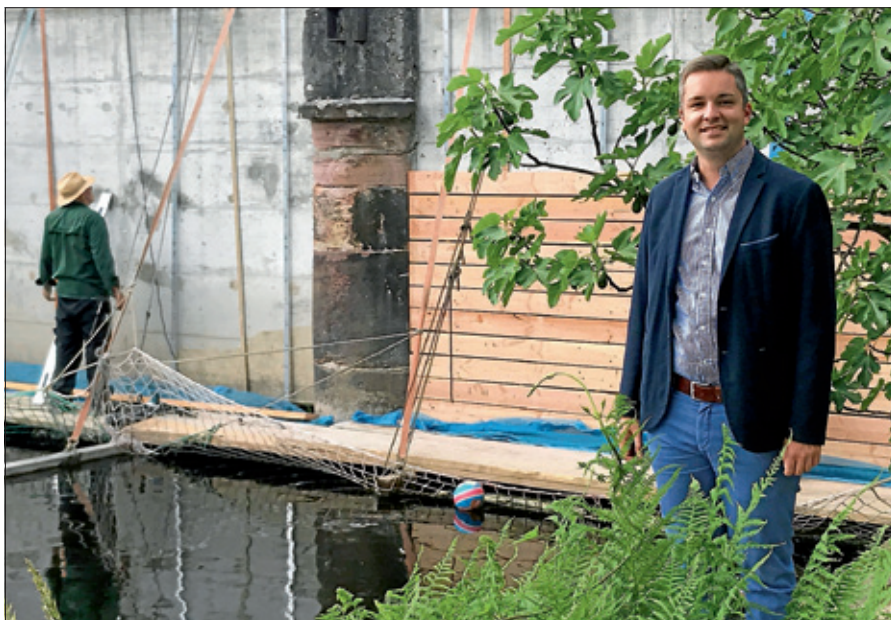
Bürgermeister Christ macht sich vor Ort am Wehr am Katz'schen Garten ein Bild über die Arbeiten zur Anbringung der Holzverkleidung.
