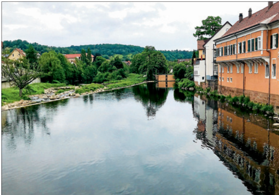
Murgansicht mit fertiggestelltem Wehr.
