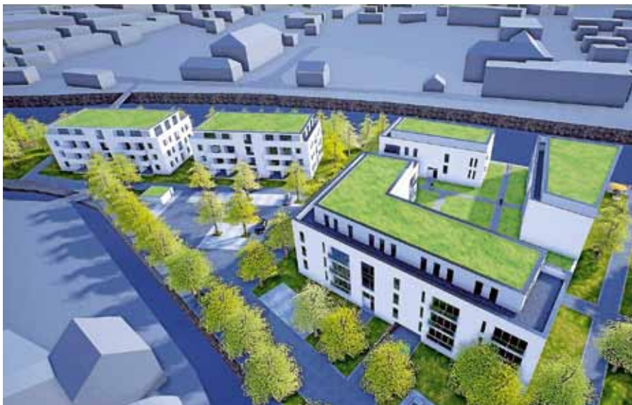
Altersgerechtes Wohnen (links) und öffentliches Gebäude (rechts).
