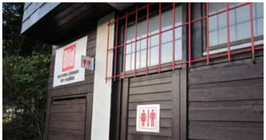
Das sanierte WC befindet sich auf der Rückseite des Bahnhofskiosks. Foto: Stadt Gernsbach.
