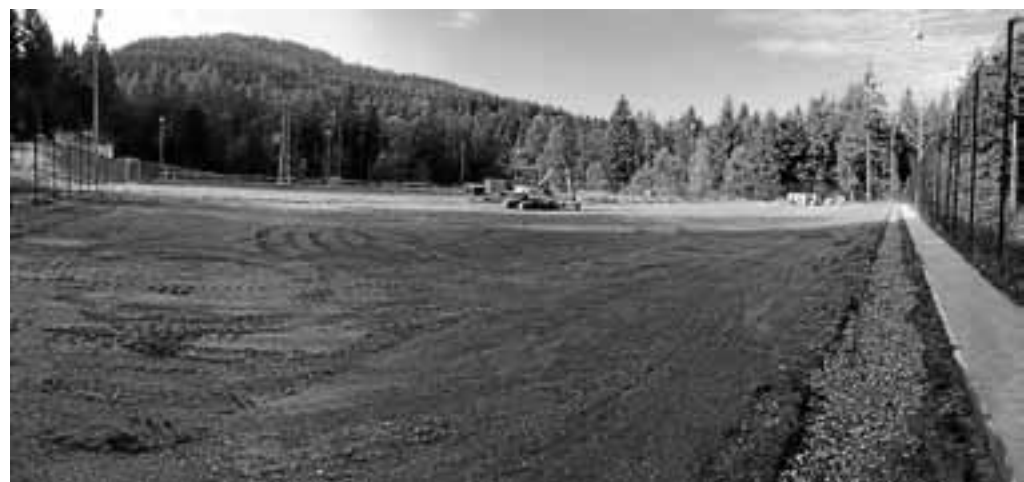
Die Platzanlage des Sportvereins Staufenberg während der Umbaumaßnahme. Foto: privat
