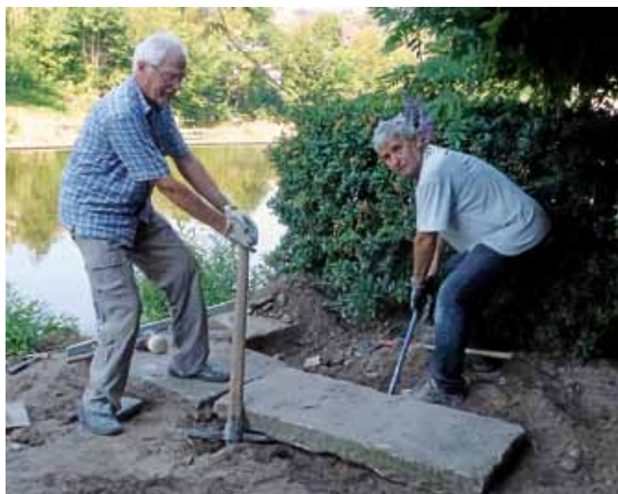
Reinhold Krieg und Sepp Kern beim Anlegen des Brunnen-Vorplatzes. Foto: J. Illig
