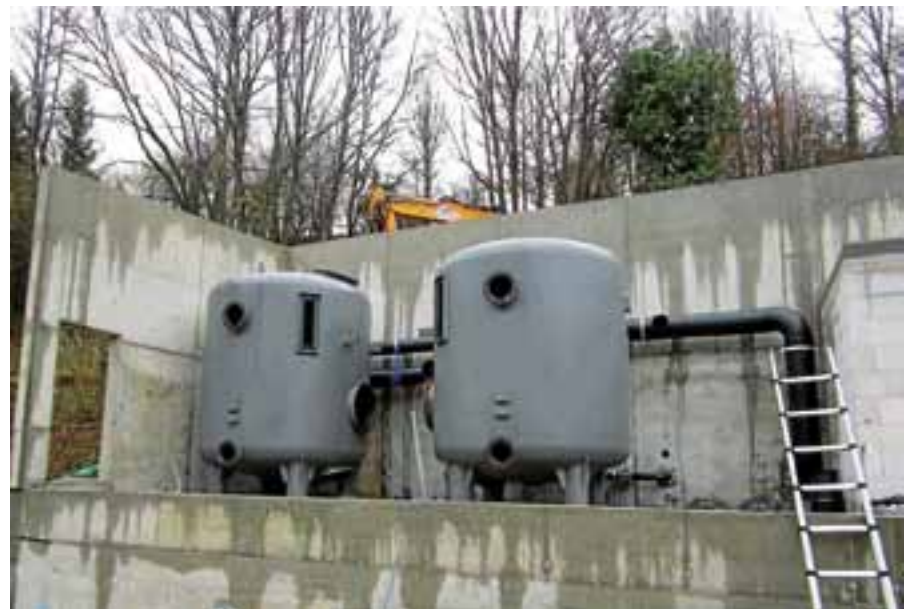
Die Sanierungsarbeiten im Schwimmbad Obertsrot schreiten voran. Kürzlich wurden die beiden Filter geliefert und an ihren Standort im künftigen Technikgebäude gebracht. Auch ein neuer Kioskpächter wird bereits gesucht. Ab Sommer bietet dann auch das Obertsroter Freibad wieder Freizeitspaß für Groß und Klein.
