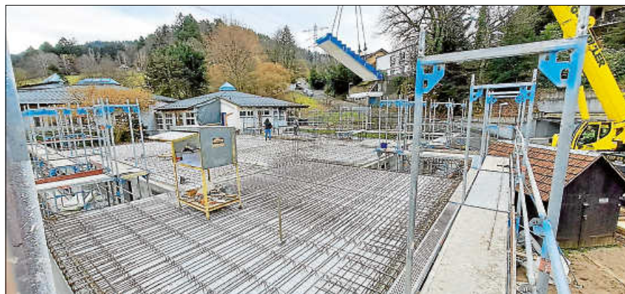
Die Bauarbeiten kommen gut voran.
