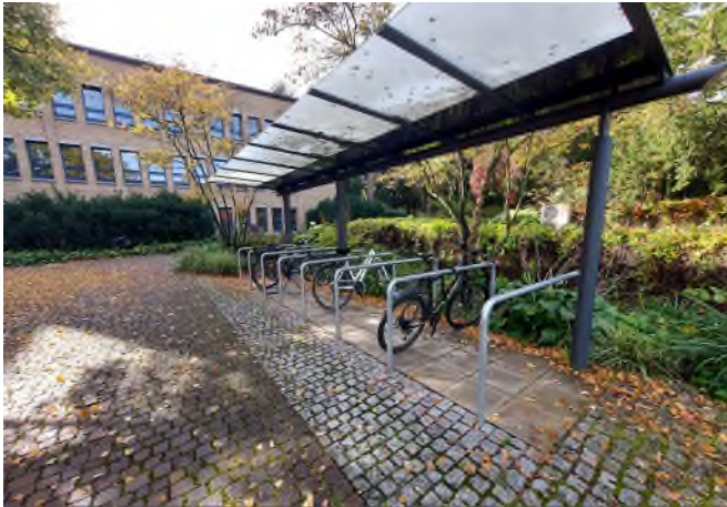
Überdachte Abstellanlage mit Anlehnhaltern in Fellbach, BW
