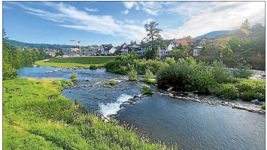
Der Fuß- und Radweg-Steg wird die Altstadt mit dem Wörthgarten verbinden.
