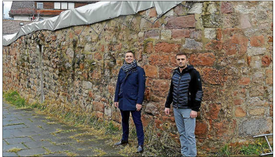
Bürgermeister Julian Christ und Projektleiter Elschad Kasimov freuen sich über den Start der Mauersanierung beim Gleisle-Areal. Foto: Stadt Gernsbach
