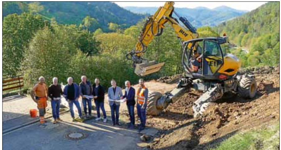
Start der Erschließungsarbeiten im Neubaugebiet ‚Hardt III Abrundung‘ in Reichtental.
