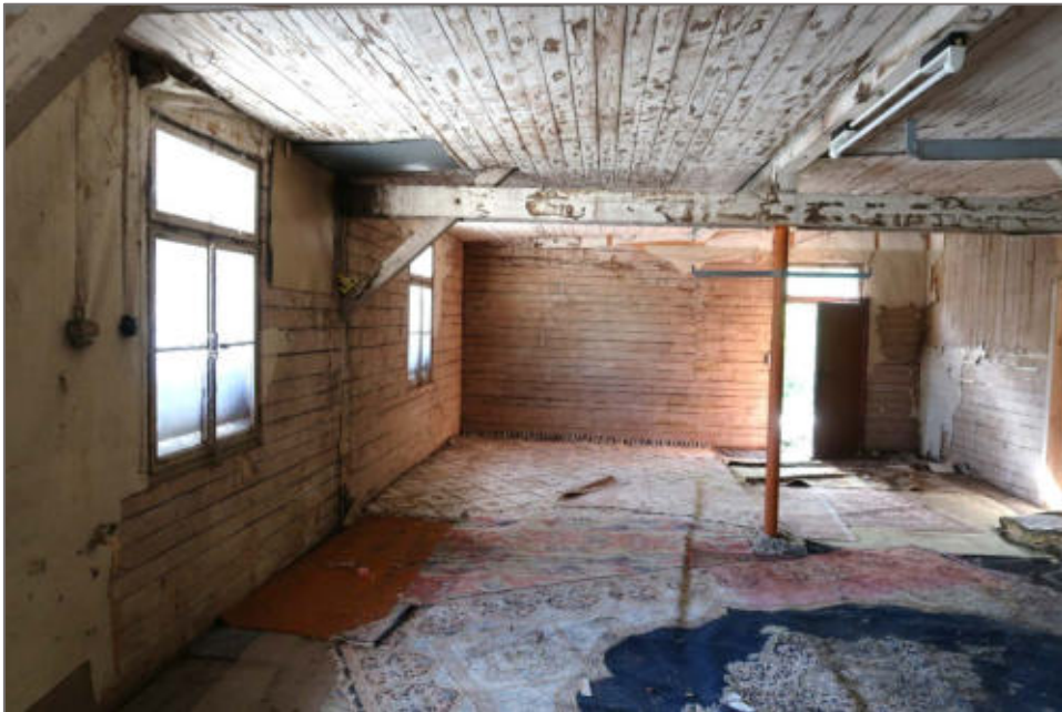
Abb. 17: Inneres des nördlich angrenzenden Anbaus (30.04.24)
