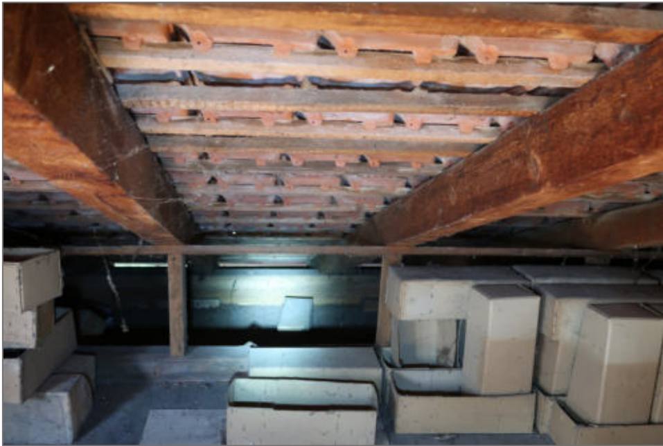
Abb. 18: Dachgeschoss der Uhlandstr. 16 (30.04.24)
