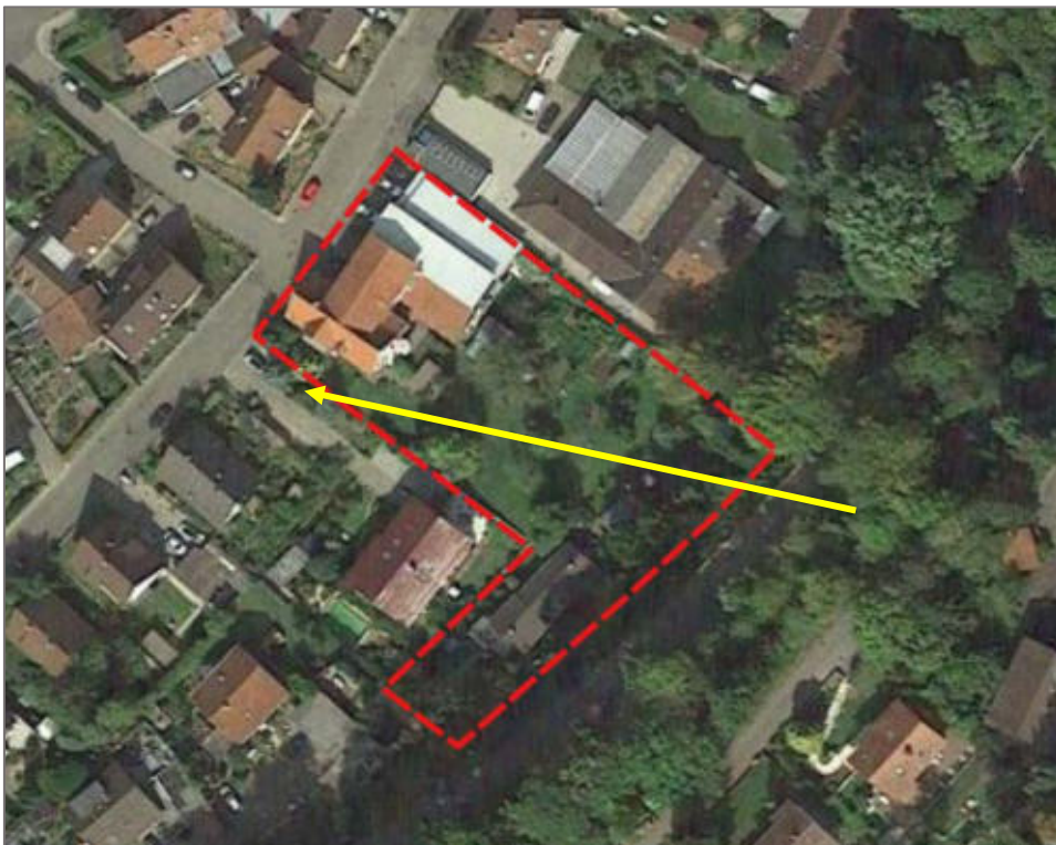
Abb. 22: Festgestellte bevorzugte Flugrichtung der Zwergfledermäuse (gelber Pfeil) im Vorhabensbereich (rote Umgrenzung) (Kartengrundlage: LGL, www.lgl-bw.de )
