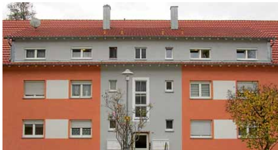
Erfolgte Fassadensanierung in der Casimir-Katz-Straße.
