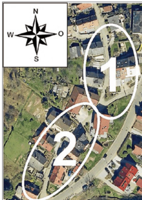
Die Maßnahme wird in zwei Bauabschnitten durchgeführt. Foto: Ingrada, Softplan Informatik GmbH
