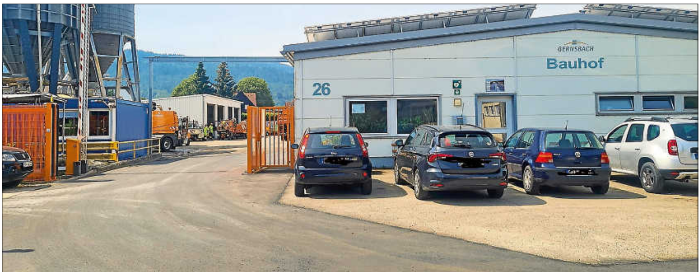
Die Zufahrt zum Bauhof wurde erneuert.
