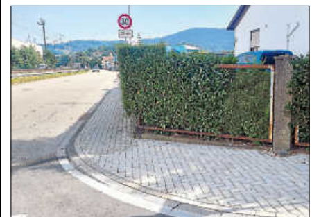
Die Bordsteine an den angrenzenden Bereichen wurden zur leichteren Begehrbarkeit abgesenkt.
