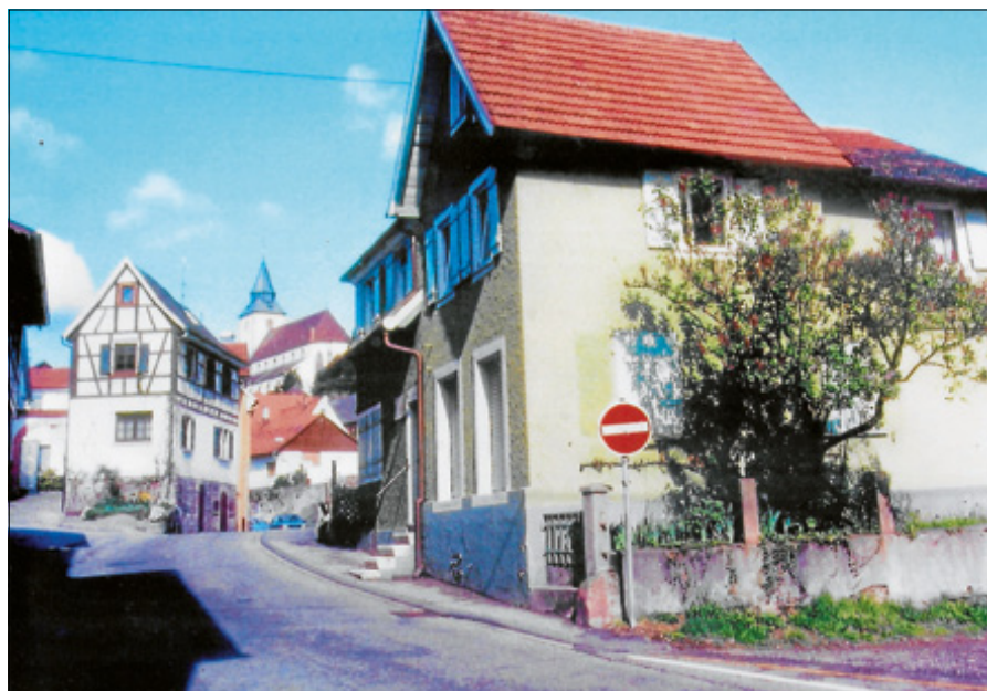
Waldbachstraße im Zuge der Sanierung.
