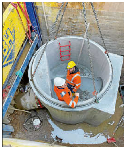
Bauarbeiter im Abwasserverband-Schacht. Foto: Stadtwerke Gernsbach
