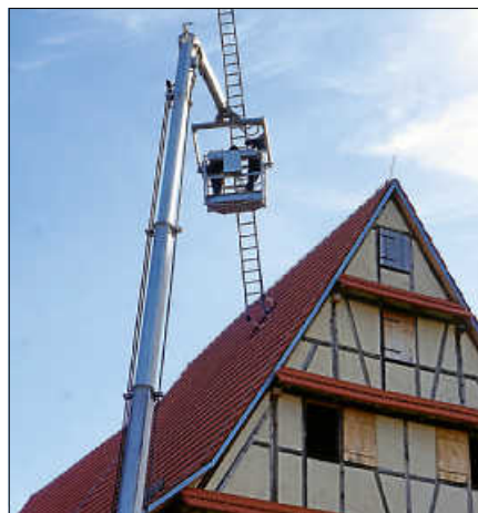
Mithilfe eines Kranwagens wurden die Tennenleitern übers Dach „eingefädelt“.
