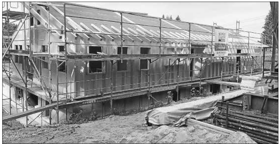
Die Auwiesenhütte des SVS nimmt langsam Formen an.
