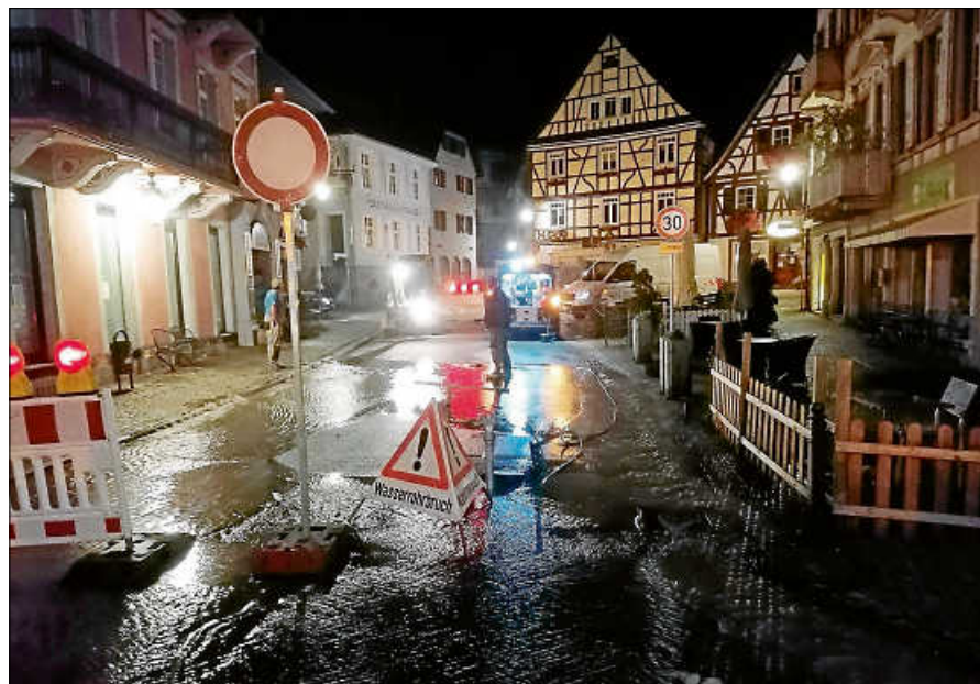
Wasserrohrbruch in der Hofstätte.
