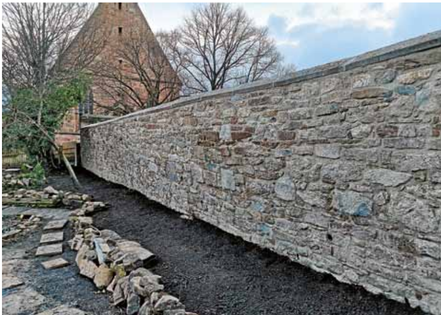
Die Friedhofsmauer ist nun statisch gesichert und optisch aufgewertet. Foto: Stadt Gernsbach
