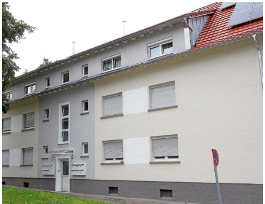
Das Wohnhaus in der Casimir-Katz-Str. 28b nach der Sanierung.
