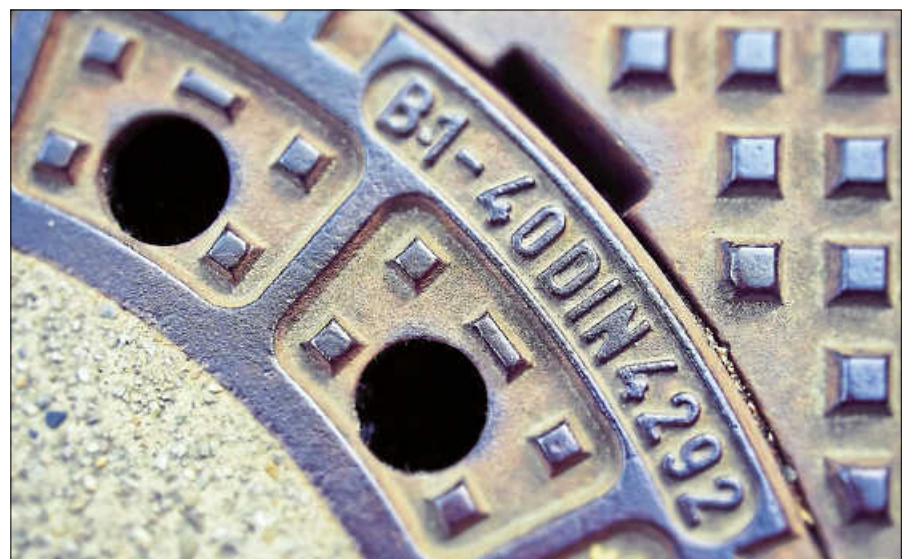
Die Straßenabläufe dienen dem Sammeln und Ableiten von Niederschlagswasser in die Kanalisation.
