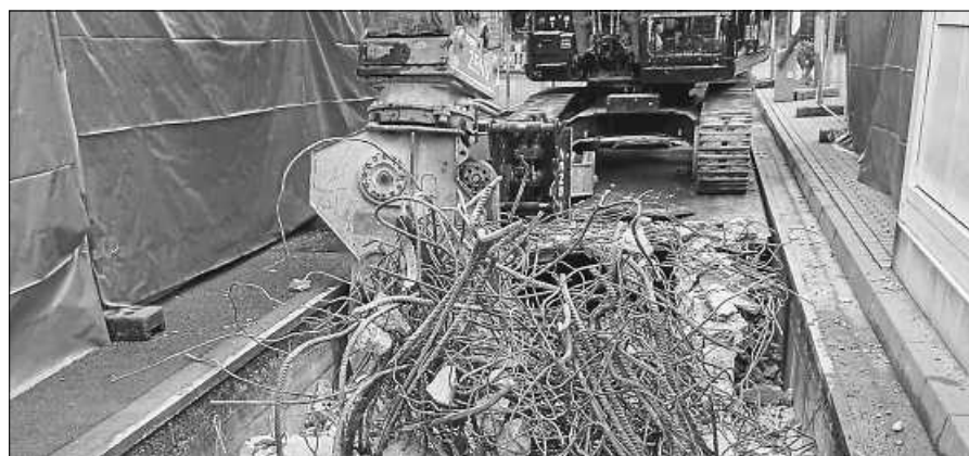
Abbruch der Waage am Eingang.
