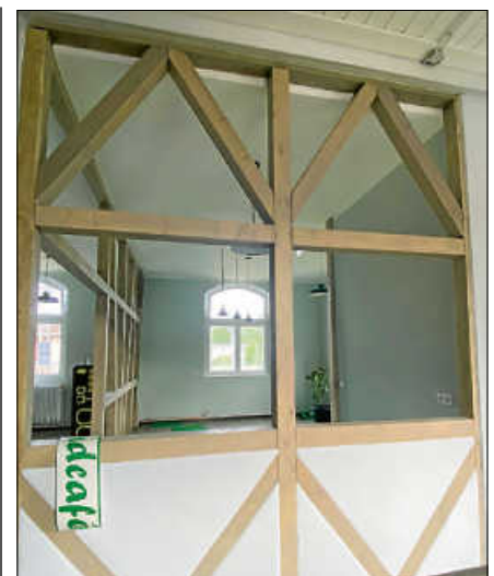
Letzte Vorbereitungsarbeiten in dem neu gestalteten Innenraum.
