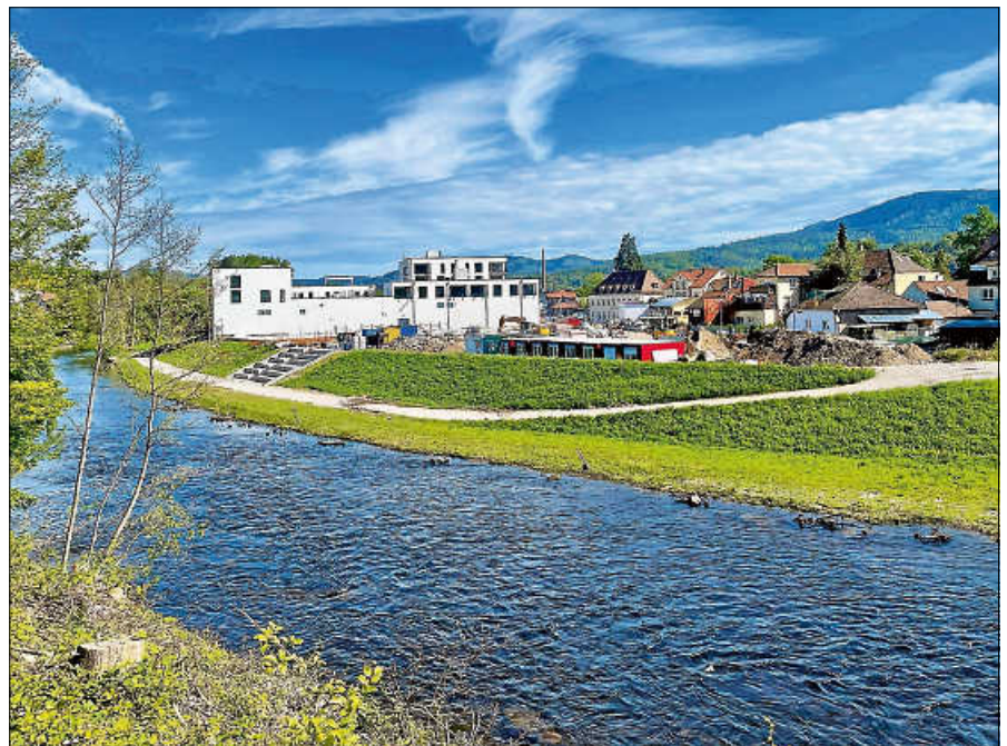
Blick auf die Murg und das Wörthgarten-Areal.
