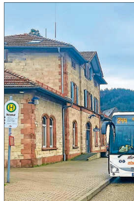
Für die Buslinien 244 und X44 gelten während der Bauzeit geänderte Fahrpläne. Foto: Stadt Gernsbach
