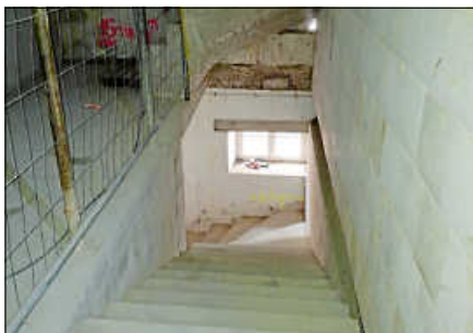
Eines der beiden neuen Treppenhäuser ist fertiggestellt.
