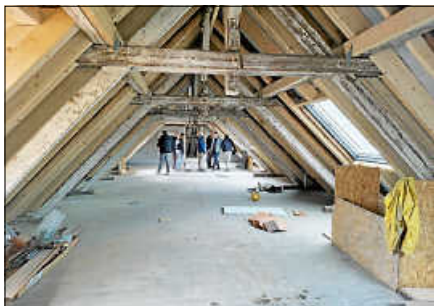
Die Struktur der Maisonettewohnungen im Obergeschoss ist geschaffen.
