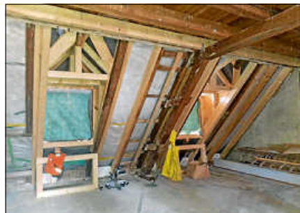
Die neuen Gauben sorgen für Raum und Licht.
