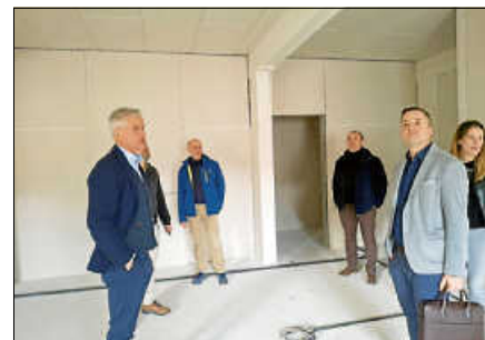
Die Räume im Obergeschoss haben deutlich Struktur angenommen.
