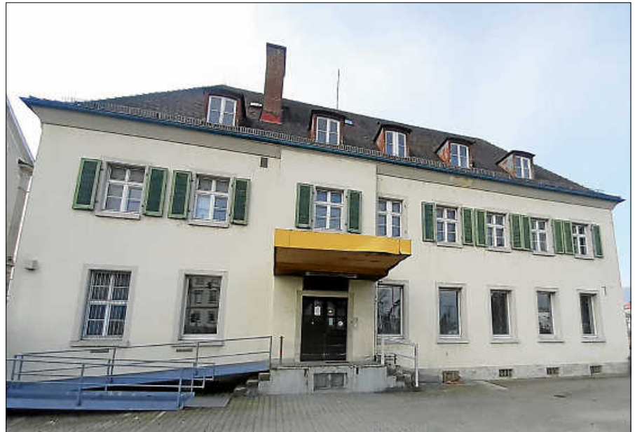
In der Kernstadt wird das Alte Postgebäude zur Unterbringung von Geflüchteten umgebaut. Foto: Stadt Gernsbach
