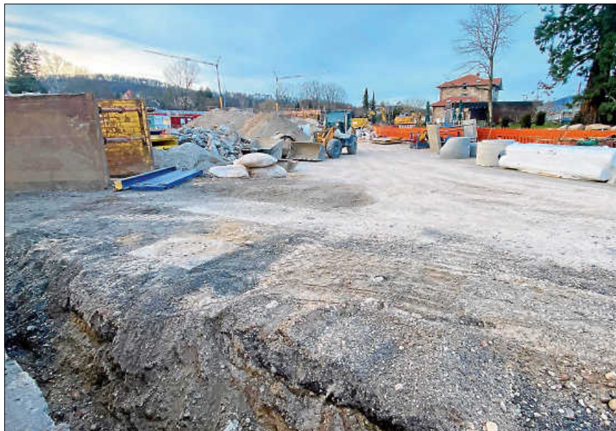
Blick auf die Baustelle.
