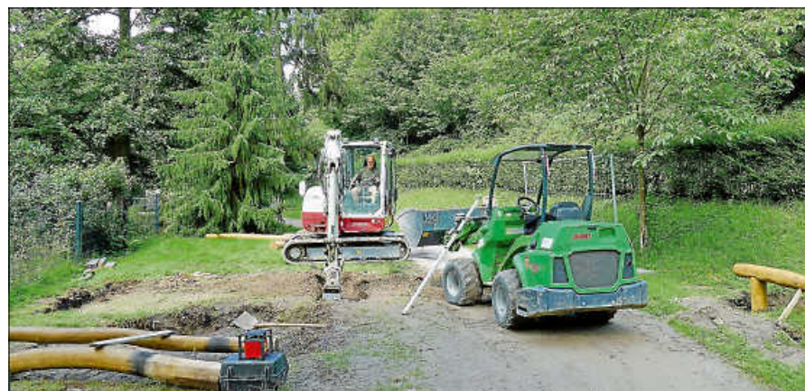
Die Bauarbeiten sind in vollem Gange.
