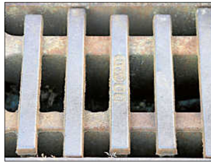
Die Straßenabläufe dienen dem Sammeln und Ableiten von Niederschlagswasser in die Kanalisation. Foto: Pixabay
