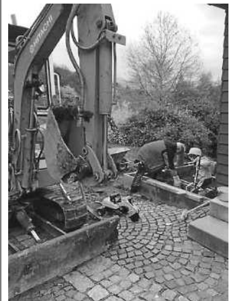
Die Bauarbeiten haben begonnen.
