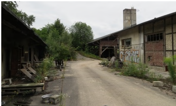
Bild 2: Ehemalige Produktionshallen (Foto 2017)
