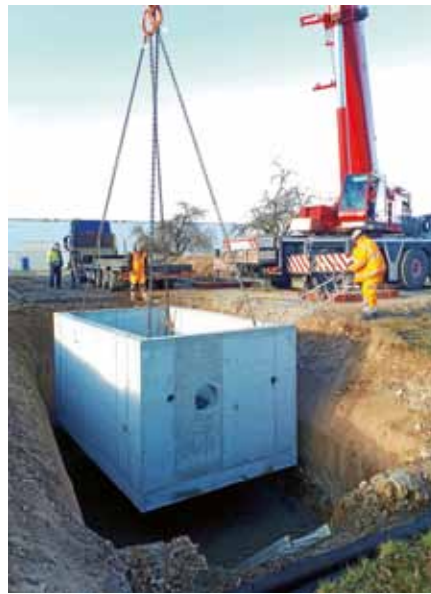
Mithilfe eines Hydraulikkrans wurde der 30 Tonnen schwere Schacht versetzt. Foto: Reif Bauunternehmung GmbH & Co. KG
