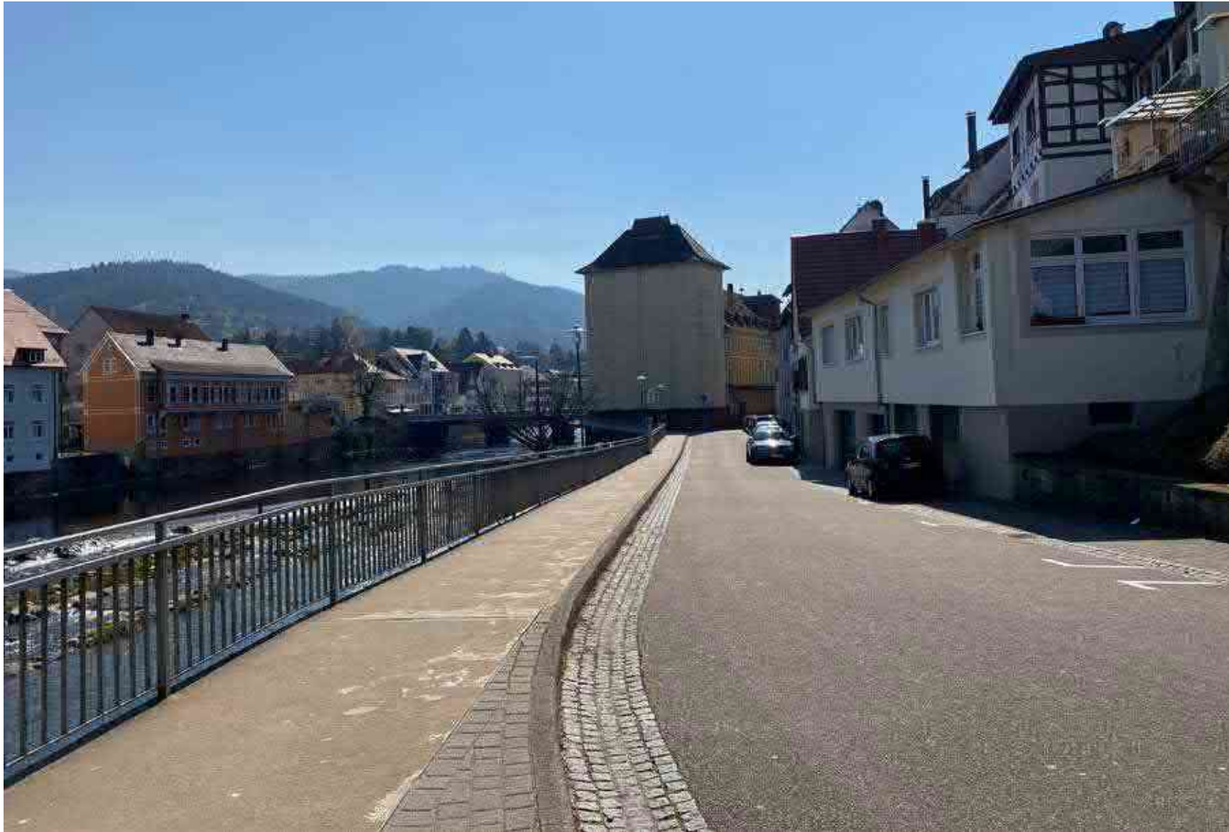
Maßnahme 8, Ist -Zustand: Sicht auf die Murg, nicht erlebbar
